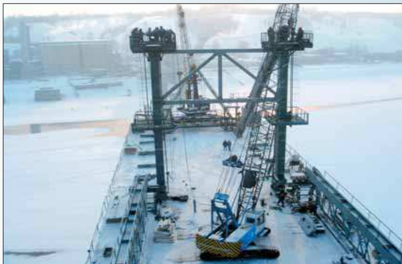
Рис. 8. Монтаж шпренгеля над опорой № 11
