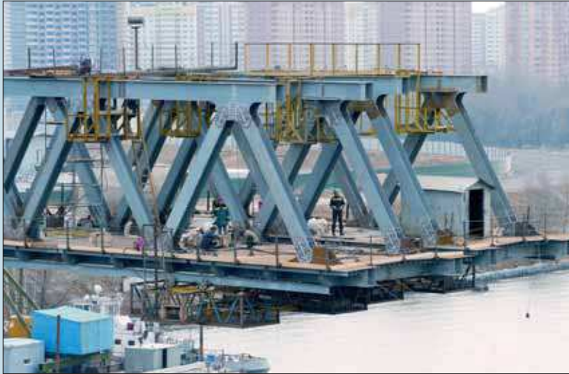
Монтаж панели фермы внавес
