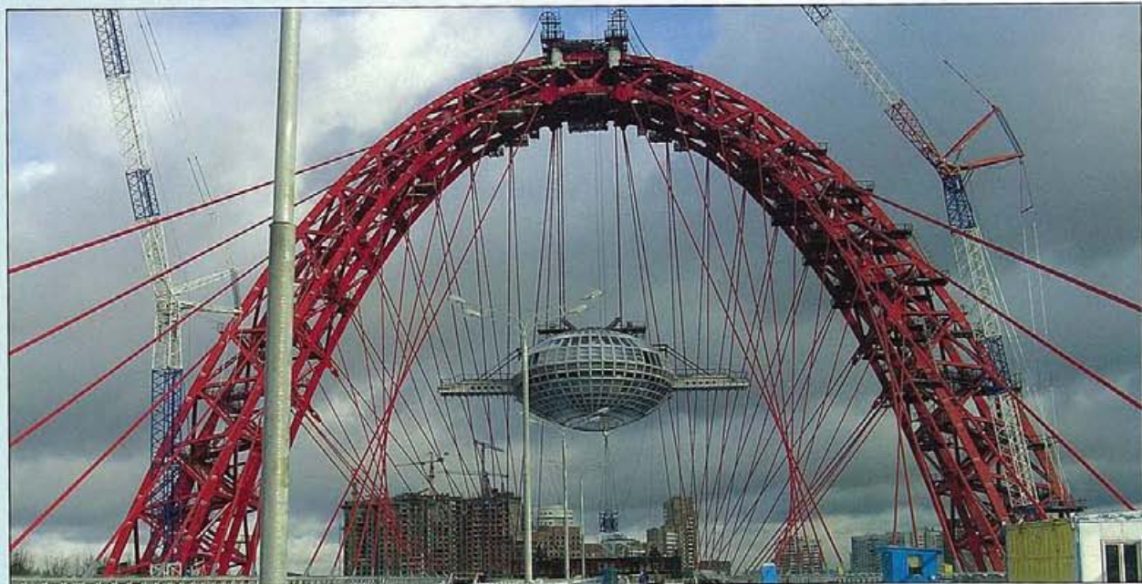
Рис. 1. Подъём смотровой площадки
