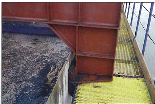
Рис. 4. Конструкция анкеровки (узел 1)
