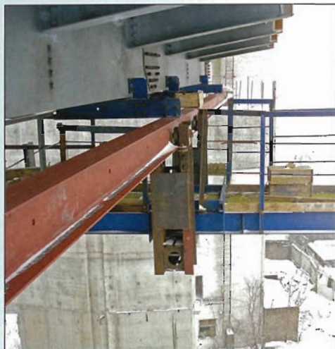
Рис. 11. Передвижные подмости нижнего пояса
