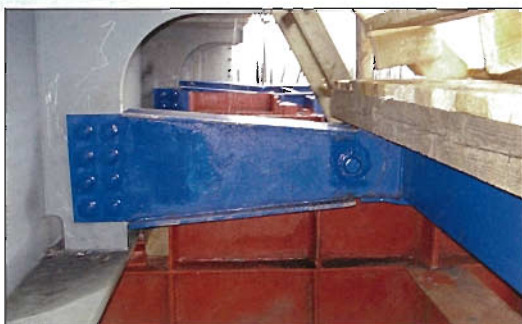
Рис. 5. Конструкция анкервки (узел 2)
